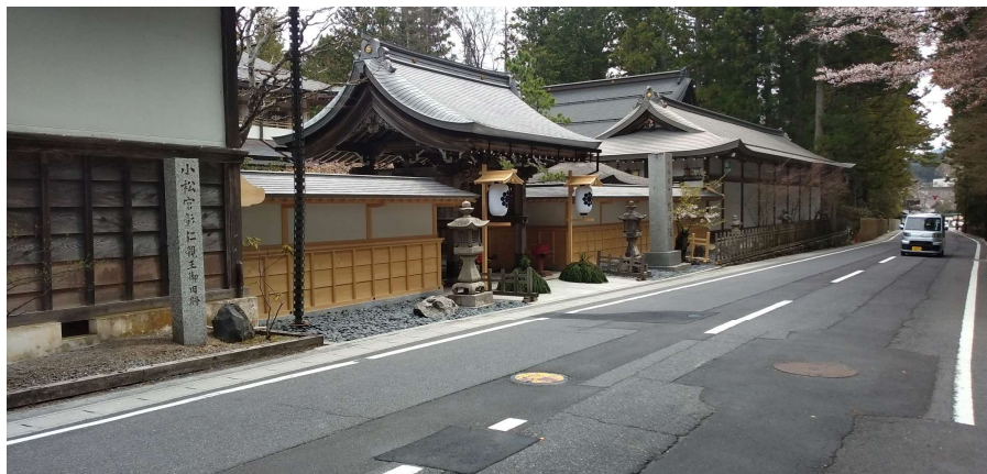
令和5年度 美しい街なみ景観整備事業による整備 総持院山門及び塀改修工事
