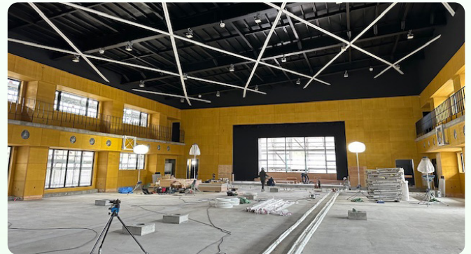
アリーナ内装工事写真
