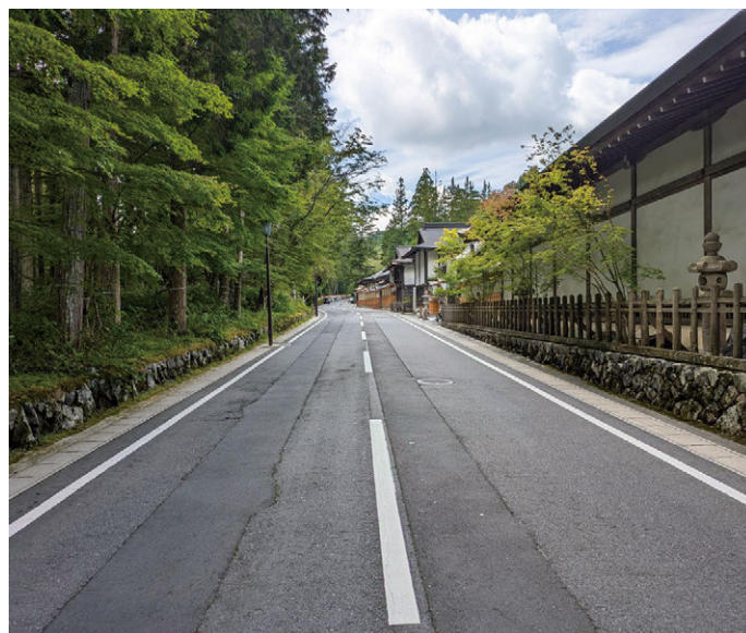
▲ 町道深山1号線無電柱化工事
