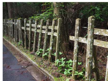
改修前の状況 R4
