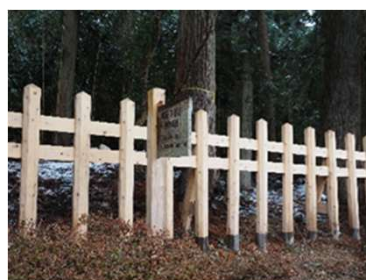
木柵の改修 R4
