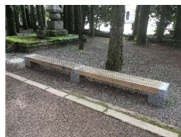
ベンチの改修 R4
