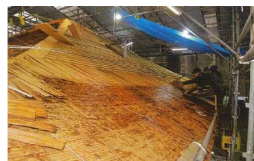
金剛三昧院経蔵 修理状況
